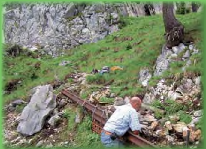
2012: Sanierung eines Elementarschadens am Dr.-Julius-Mayr-Weg
