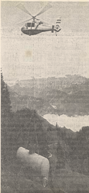
Auf dem Brünstein ratterten Baumaschinen: Die Wasserversorgung des DAV-Brünsteinhauses wurde erweitert und eine neue Kläranlage installiert. Der neue Wasserbehälter im Gewicht von 1,2 Tonnen wurde mit einem Hubschrauber auf den Berg gebracht. Foto: Seebacher
