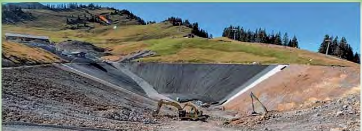
So gut wie fertig: der umstrittene Speicherteich, der das Skigebiet Sudelfeld schneesicherer machen soll.
