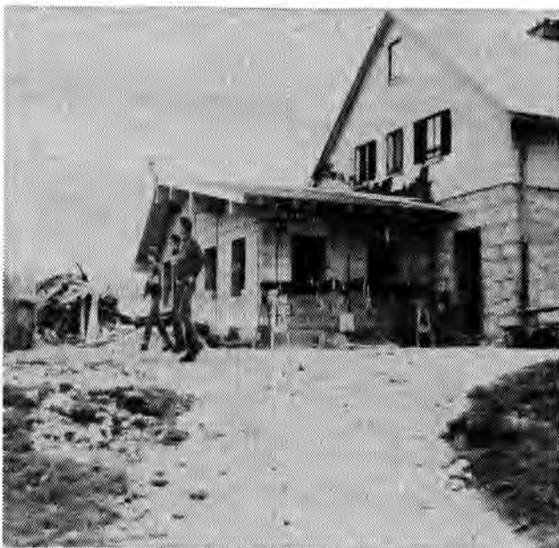
Richtfest auf der Hochries: Der Anbau ist nun bis zum Rohbau gediehen.
