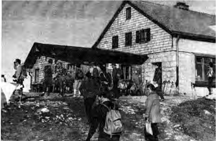
Durch den neuen Anbau wurde das Hochries-Gipfelhaus zu einem schmucken Bergsteigerheim. Am Sonntag war der Hochriesgipfel von rund 1000 Wanderern bevölkert. In der Hütte gab es über mehrere Stunden hinweg keinen freien Platz. Fotos:
