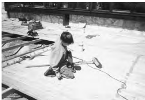
Der Bau der Terrasse nimmt Gestalt an
