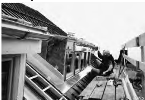
Arbeiten am Dach
