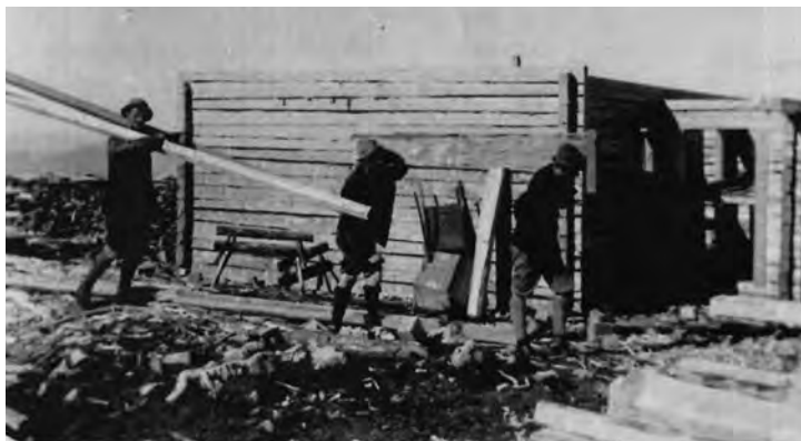
Bau der Hochrieshütte September 1913
