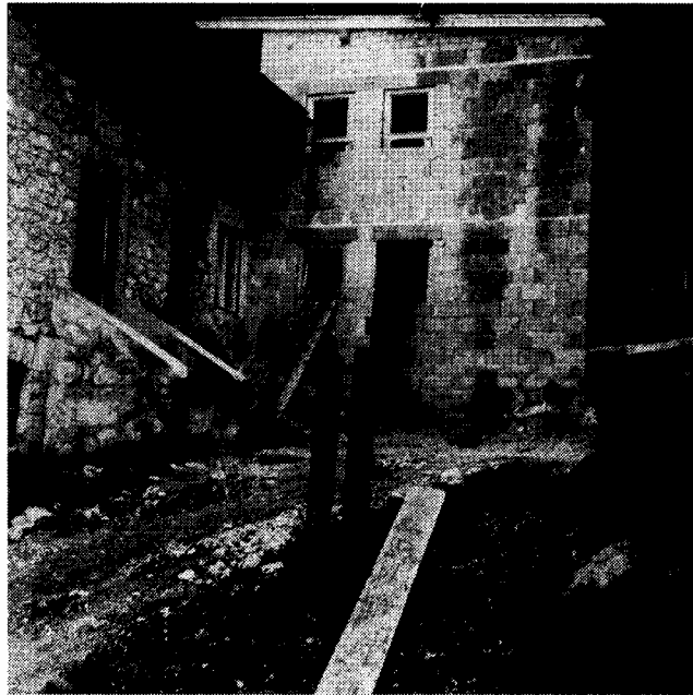
Hüttensanierung und erster Bauabschnitt 1966 – Anbau für neue Sanitäranlagen.
